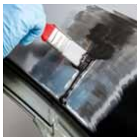
Beskyttelse av overflatelag med TEROSON EP 5055
