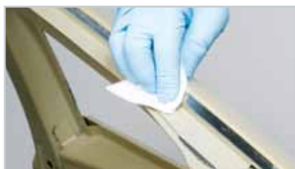
Rask og korrekt klargjøring av overflaten
