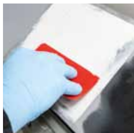
Påføring av fin fyllmasse TEROSON UP 335 FF
