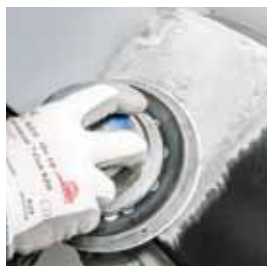
Sliping til jevn overflate
