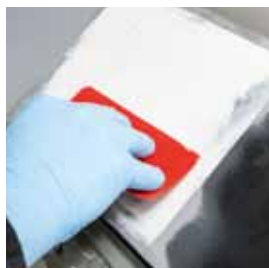
Påføring av fin fyllmasse TEROSON UP 335 FF
