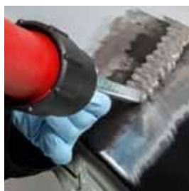
Påføring av TEROSON EP 5010 TR
