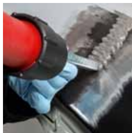
Påføring av Teroson EP 5010 TR
